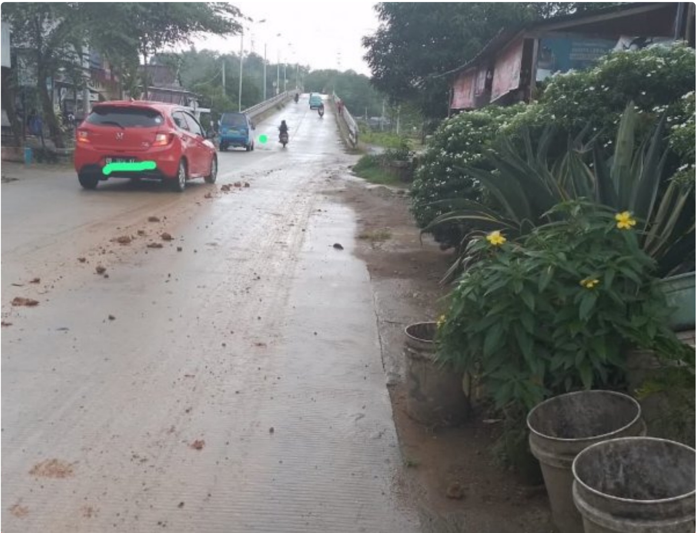
Tampak material tanah yang tercecer dari truk di jalan raya Kessie, Flay Over Pekkae
